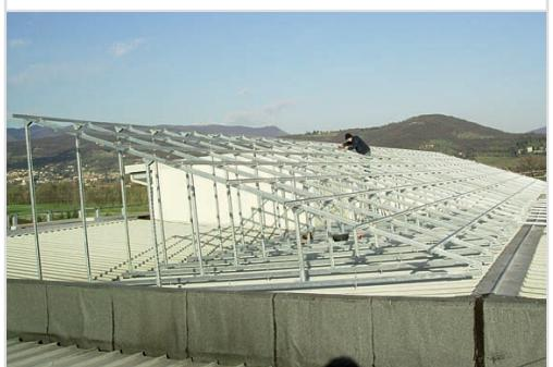
**Полная монтажная система, предназначенная для выполнения работ по монтажу:**
