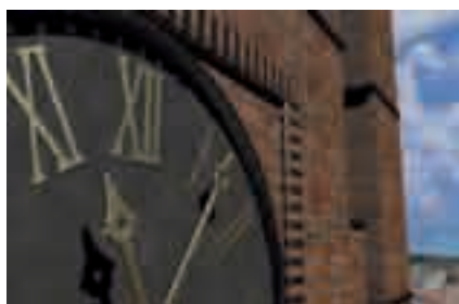
Восстановление наружного слоя
