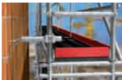
Крепление строительных лесов
