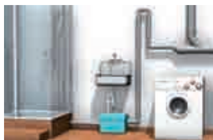
Водопроводные трубы с давлением до 1,5 бар
