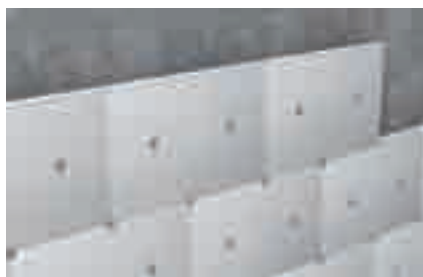
Прочные на сжатие изоляционные панели в штукатурных теплоизоляционных системах
