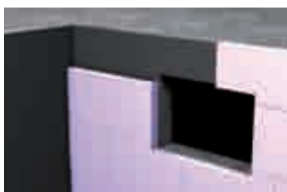
Герметизация термоизоляционных панелей
