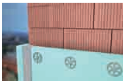
Заполнение полостей в изоляции
