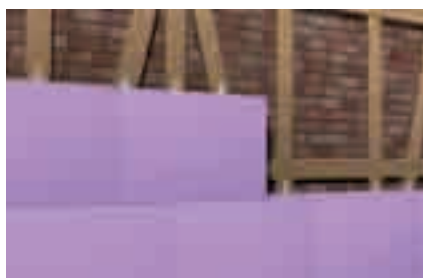
Прочные на сжатие термоизоляционные панели в деревянных подконструкциях
