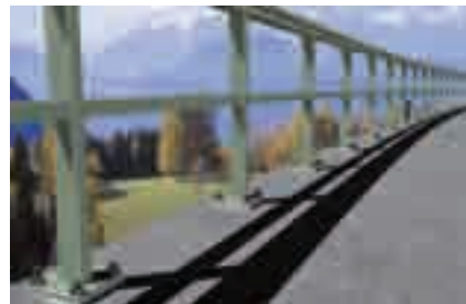
Перильные ограждения мостов
