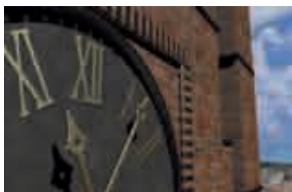
Ремонт наружных панелей
