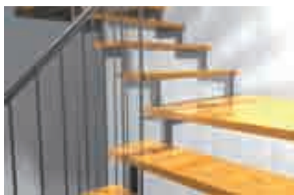
Лестничные ступени на стальных лестничных балках
