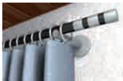
Ремонт кронштейнов для занавесей
