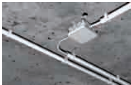
Крепление пластмассовых изоляционных труб
