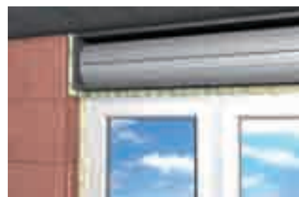
Швы в месте крепления оконных жалюзи
