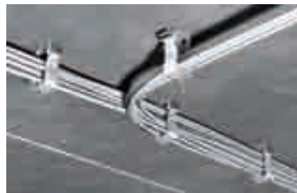
Крепление пучков кабелей
