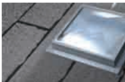
Герметизация вокруг мансардных окон
