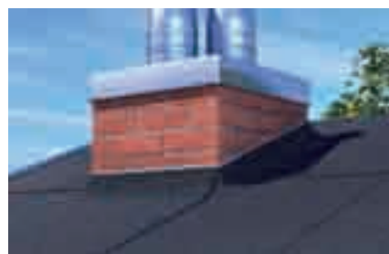
Герметизация кровли с применением листового битума
