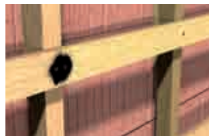
Герметизация головок шурупов
