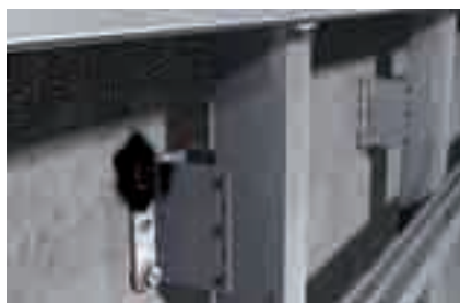
Герметизация головок шурупов
