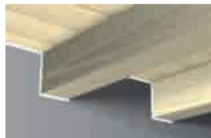
Компенсационные швы внутри помещений
