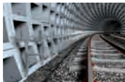
Монтаж в туннелях
