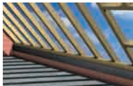
Крепление кровельной обрешетки
