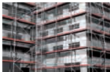
Фасадные строительные леса
