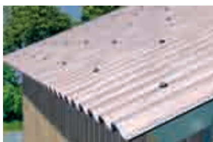
Крепление кровельного шифера
