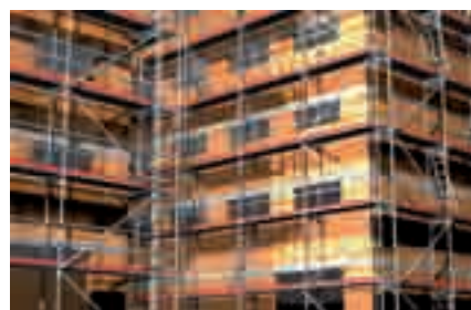
Фасадные строительные леса
