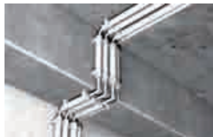
Крепление пластмассовых изоляционных труб
