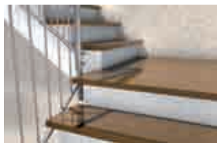
Лестничные ступени на бетонных лестничных балках
