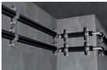
Крепление стальных трубопроводов в защитной оболочке
